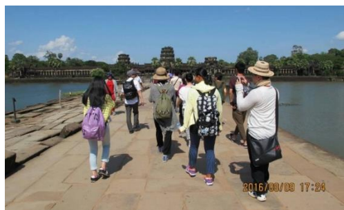
▲道の左側の地面はボコボコになっており、インドが修復した箇所。修復技術が不十分な場合、何十年か後にはこのようになってしまいます。これから日本のチームが再度修復するそうです。
